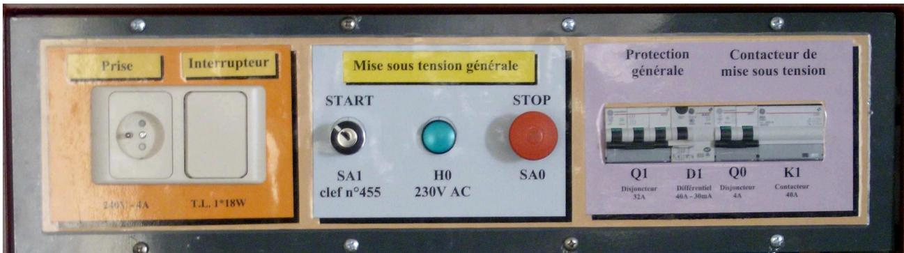
Cette vue représente le fronton de distribution électrique réalisé et utilisé sur chaque armoire didactique. Le principe de fonctionnement est identique pour toutes les armoires placées dans le local C14. Ce fronton sert principalement à isoler complètement l'installation du réseau. L'autorisation de mise sous tension ne pourra être réalisée que sous la supervision du professeur. Lui seul est habilité à mettre l'armoire sous tension, après avoir prit les mesures de sécurité nécessaires.
